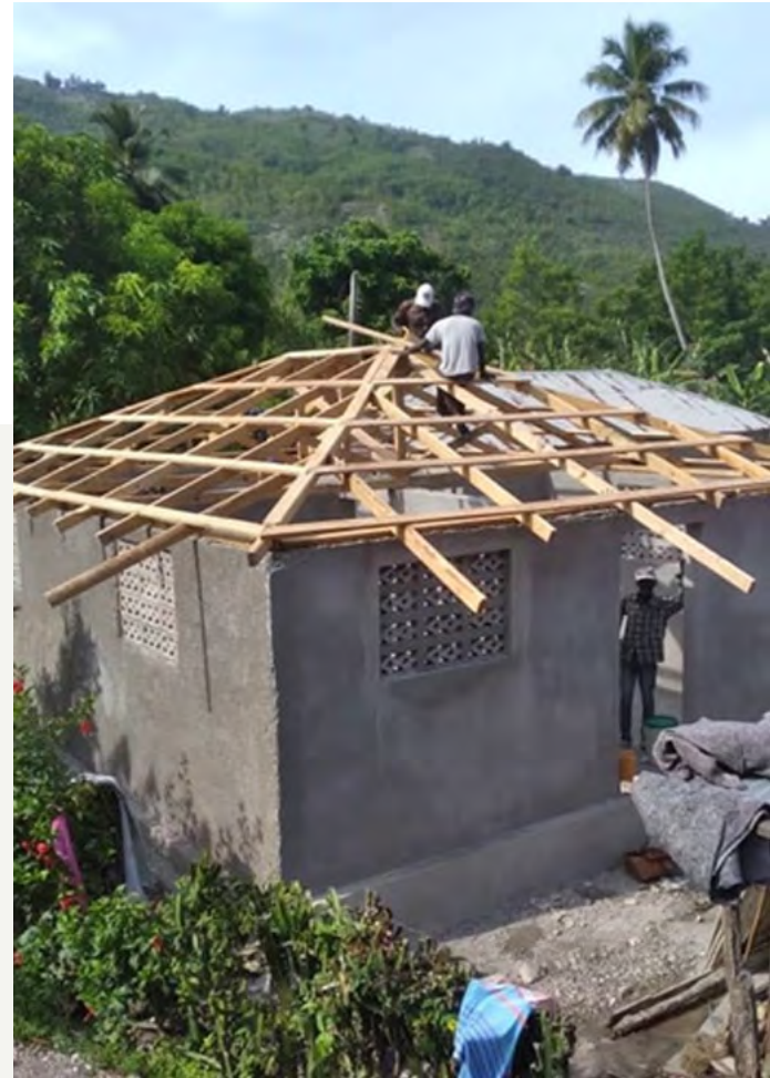
Maison en construction dans le département de Grand'Anse
