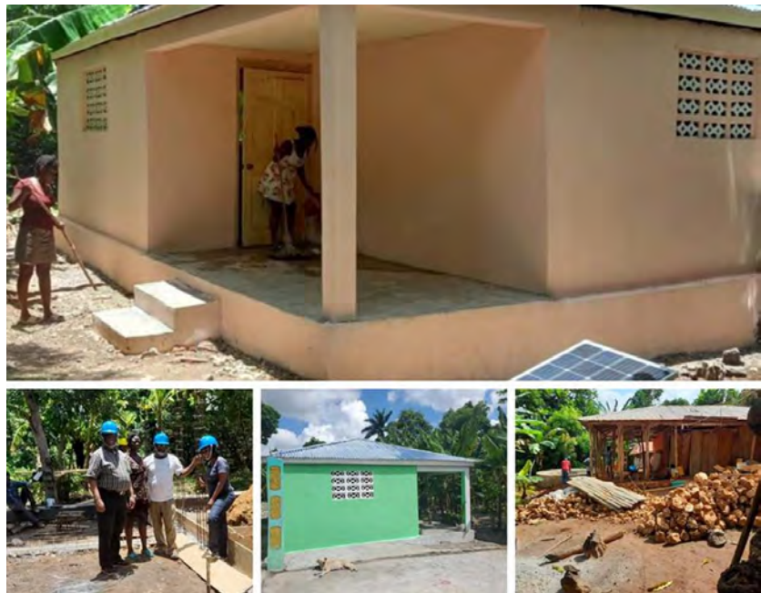
Les familles les plus vulnérables des départements du Sud et de la Grand'Anse seront relogées dans de nouvelles maisons équipées de dispositifs antisismiques et anticycloniques
